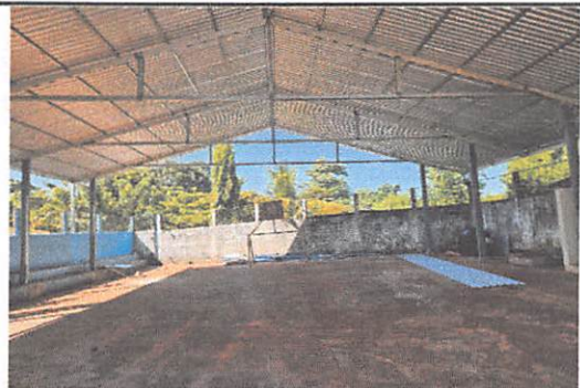
Foto 2: Sustitución de lamina por lamina troquelada Calibre 26
