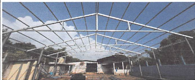
Foto 1: Sustitución de estructura de soporte de madera por metal
