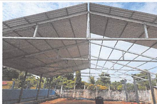
Foto 2: Sustitución de lamina por lamina troquelada Calibre 26
