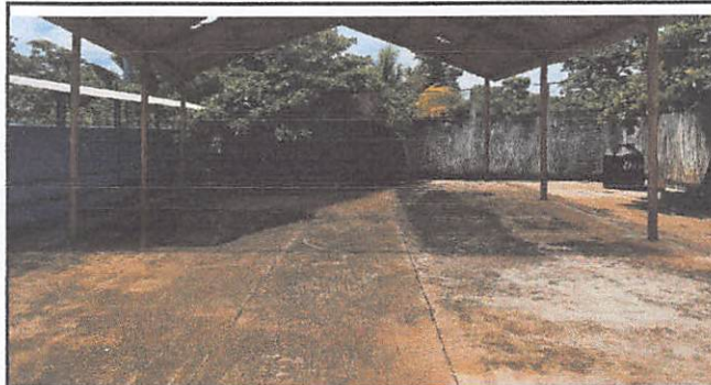
Foto 2: Sustitución de lamina por lamina troquelada Calibre 26
