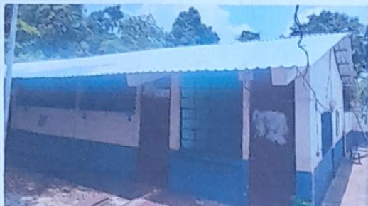
Foto1: Sustitución de lámina, por lámina troquelada cal.26 Modulo 1
