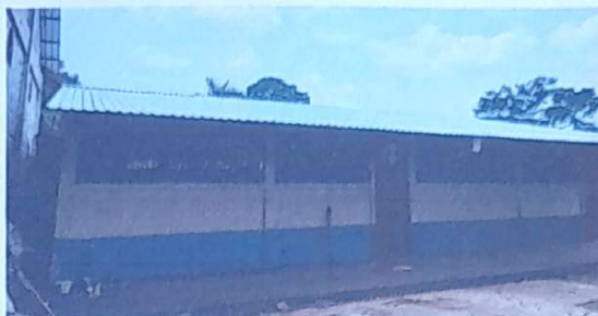
Foto 2: Sustitución de lámina, por lámina troquelada cal.26 Modulo 2
