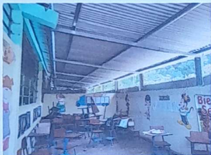
Foto 3: Sustitución de estructura de madera a estructura metálica con costanera galvanizada.
