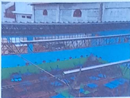
Foto 1: Reparación de estructura portante con tubo de 1" X 1 1/2" + colocación de lamina troquelada calibre 26 modulo 1
