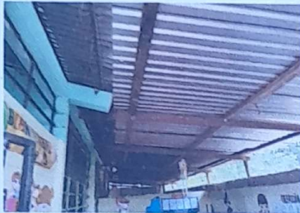
Sustitución de estructura de madera a estructura metálica con costanera galvanizada.
