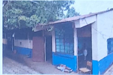
Sustitución de lámina, por lámina troquelada cal.26 Modulo 2
