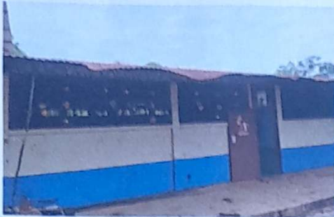
Sustitución de lámina, por lámina troquelada cal.26 Modulo 1
