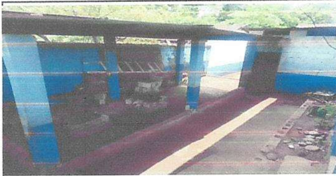
SUSTITUCION DE LAMINA, POR LAMINA TROQUELADA CAL26
