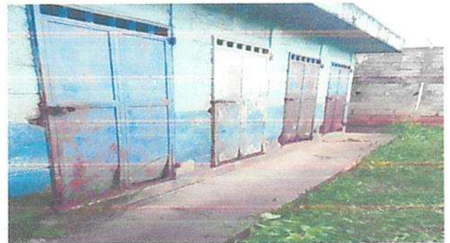
SUSTITUCION DE PUERTAS METÁLICAS (BAÑOS)
