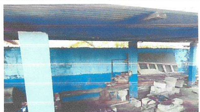
SUSTITUCION DE ESTRUCTURA DE SOPORTE MADERA, POR METAL
