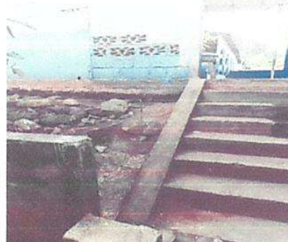
REPARACION DE MURO CON BLOCK 50KG/CM2 14*19*39CM AULA
