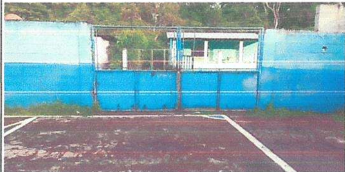
REPARACION Y MANTENIMIENTO PORTON DE METAL
