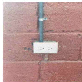
FOTO 8: SUSTITUCION DE TOMACORRIENTES DOBLES, MÓDULO 1
