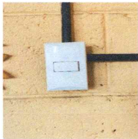
FOTO 9: SUSTITUCION DE INTERRUPTORES SIMPLES, MÓDULO 1
