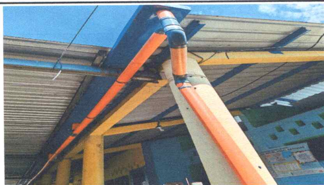
FOTO 3: SUSTITUCION DE CANAL DE METAL, MÓDULO 1
