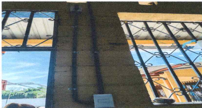
FOTO 7: REPARACION DE CABLEADO ELECTRICO Y ENTUBADO CALIBRE 12 AWG, MÓDULO 1
