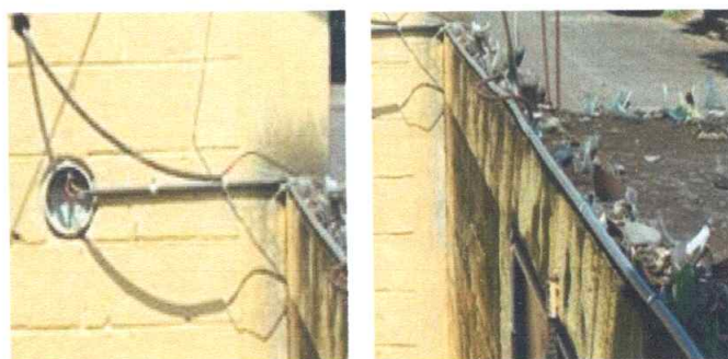
FOTO 6: REPARACION DE CABLEADO ELECTRICO Y ENTUBADO CALIBRE 10 AWG, MÓDULO 1
