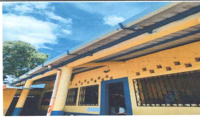
FOTO 2: SUSTITUCIÓN DE ESTRUCTURA DE SOPORTE DE METAL POR METAL, MÓDULO 1
