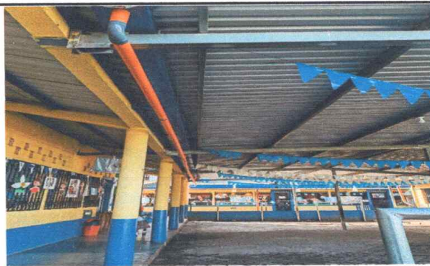
FOTO 4: MANTENIMIENTO DE CANALES DE METAL , MÓDULO 1
