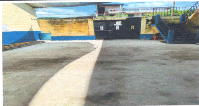
FOTO 5: REPARACION FIRME DE CONCRETO DE 2 CMS CON ACABADO GRIS, DE AREA 123 METROS CUADRADOS EN EL AREA RECREATIVA PRINCIPAL
