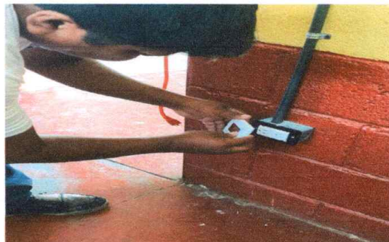
FOTO 8: SUSTITUCION DE TOMACORRIENTES DOBLES, MÓDULO 1
