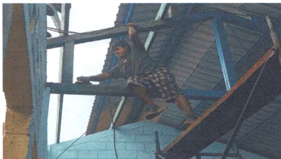
FOTO 1: MANTENIMIENTO A ESTRUCTURA DE SOPORTE DE METAL CON ANTICORROSIVO, MÓDULO 1
