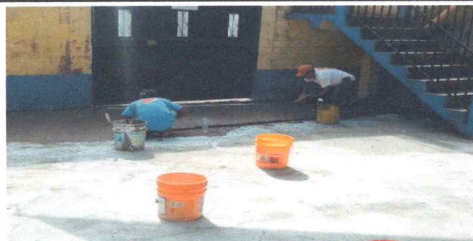
FOTO 5: REPARACION FIRME DE CONCRETO DE 2 CMS CON ACABADO GRIS, DE 123 METROS CUADRADOS EN EL AREA RECREATIVA PRINCIPAL
