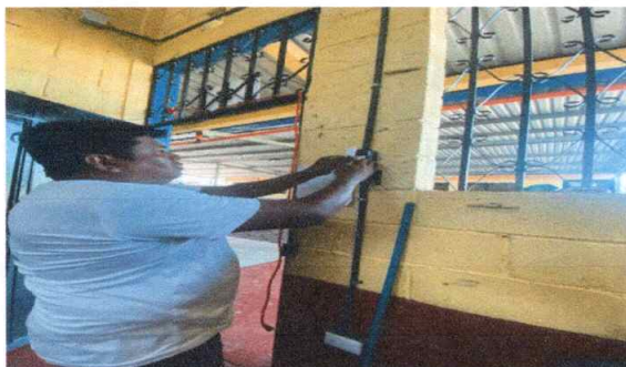
FOTO 9: SUSTITUCION DE INTERRUPTORES SIMPLES, MÓDULO 1
