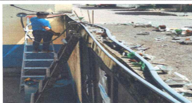
FOTO 6: REPARACION DE CABLEADO ELECTRICO Y ENTUBADO CALIBRE 10 AWG, MÓDULO 1
