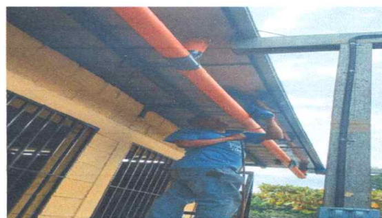
FOTO 4: MANTENIMIENTO DE CANALES DE METAL, MÓDULO 1
