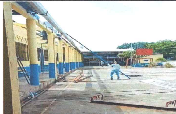
FOTO 2: SUSTITUCIÓN DE ESTRUCTURA DE SOPORTE DE METAL POR METAL, MÓDULO 1
