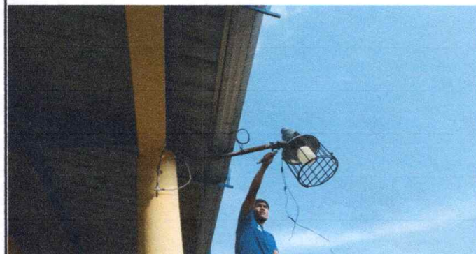
FOTO 10: SUSTITUCION DE LAMPARA EXISTENTE CON LAMPARA BOMBILLO LED, MÓDULO 1
