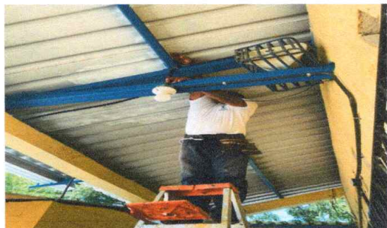
FOTO 11: REPARACION DE CABLEADO ELECTRICO Y ENTUBADO CALIBRE 10 AWG, MÓDULO 1
