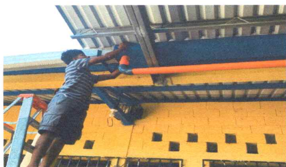
FOTO 3: SUSTITUCION DE CANAL DE METAL, MÓDULO 1
