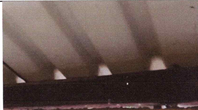
FOTO 1: SUSTITUCION DE ESTRUCTURA DE SOPORTE METAL POR METAL, MÓDULO 1
