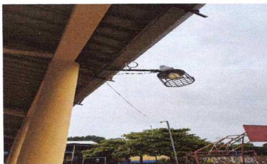
FOTO 10: SUSTITUCION DE LAMPARA EXISTENTE CON LAMPARA BOMBILLO LED, MÓDULO 1
