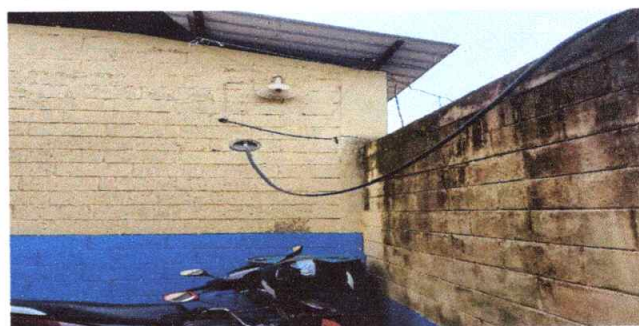
FOTO 6: REPARACION DE CABLEADO ELECTRICO Y ENTUBADO CALIBRE 10 AWG, MÓDULO 1
