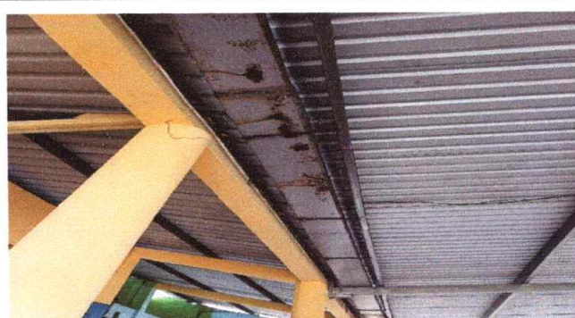
FOTO 4: MANTENIMIENTO DE CANALES DE METAL , MÓDULO 1
