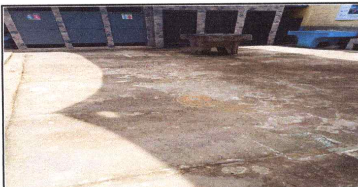
FOTO 5: REPARACION FIRME DE CONCRETO DE 2 CMS CON ACABADO GRIS, AREA RECREATIVA PRINCIPAL
