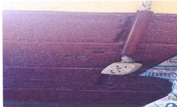
FOTO 8: SUSTITUCION DE TOMACORRIENTES DOBLES, MÓDULO 1
