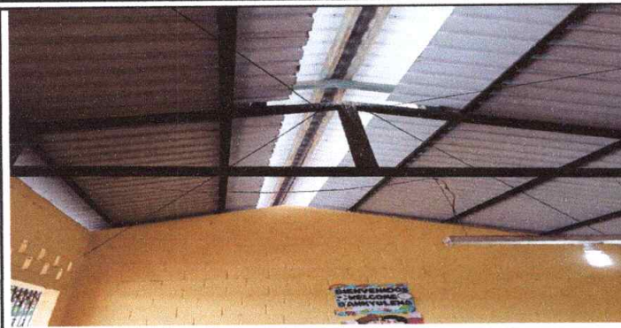
FOTO 1: MANTENIMIENTO A ESTRUCTURA DE SOPORTE DE METAL CON ANTICORROSIVO ,ANTES MÓDULO 1
