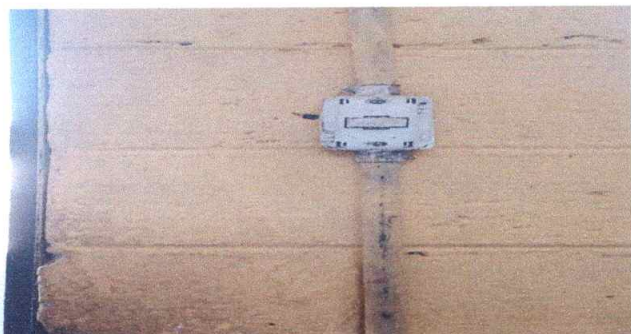
FOTO 9: SUSTITUCION DE INTERRUPTORES SIMPLES, MÓDULO 1
