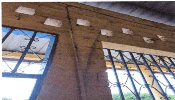
FOTO 7: REPARACION DE CABLEADO ELECTRICO Y ENTUBADO CALIBRE 12 AWG, MÓDULO 1
