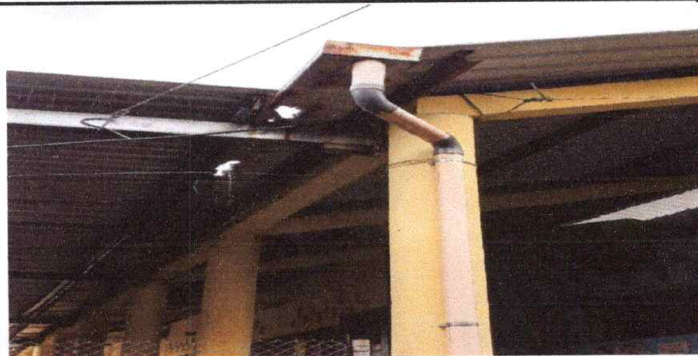
FOTO 3: SUSTITUCION DE CANAL DE METAL, MÓDULO 1
