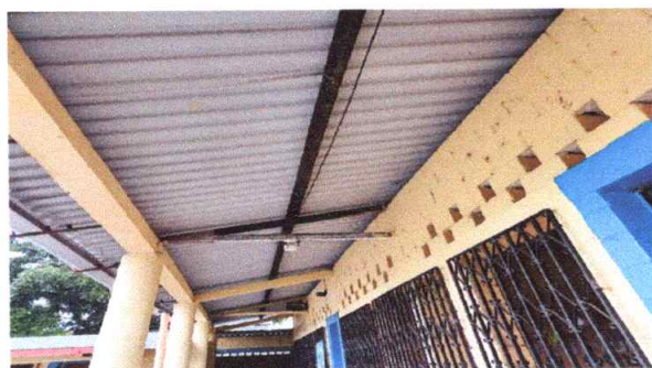
FOTO 5: REPARACION DE CABLEADO ELECTRICO Y ENTUBADO CALIBRE 10 AWG, MÓDULO 1
