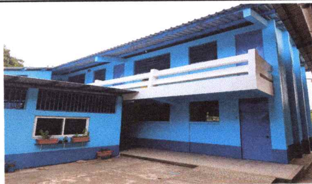
Foto 2: SUMINISTRO Y APLICACIÓN PINTURA EXTERIOR EN MUROS
