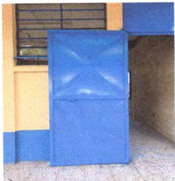
Foto 1: MANTENIMIENTO A PUERTA, LIJADO CAMBIO DE TUBO Y LAMINA Y PINTURA ANTICORROSIVA
