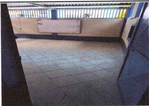
Foto 3: SUSTITUCIÓN DE PISO DE CONCRETO POR CERÁMICO
