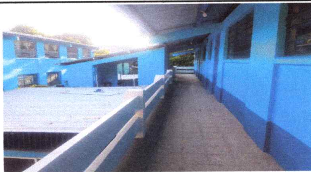
Foto 4: SUMINISTRO Y APLICACIÓN PINTURA EXTERIOR EN MUROS
