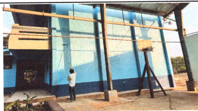
Foto 5: SUMINISTRO Y APLICACIÓN PINTURA EXTERIOR EN MUROS
