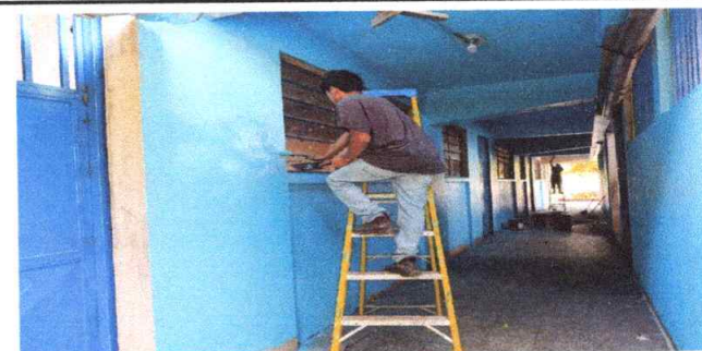
Foto 6: SUMINISTRO Y APLICACIÓN PINTURA EXTERIOR EN MUROS
