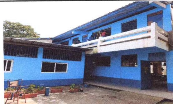
Foto 2: SUMINISTRO Y APLICACIÓN PINTURA EXTERIOR EN MUROS
