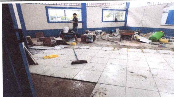
Foto 3: SUSTITUCIÓN DE PISO DE CONCRETO POR CERÁMICO
