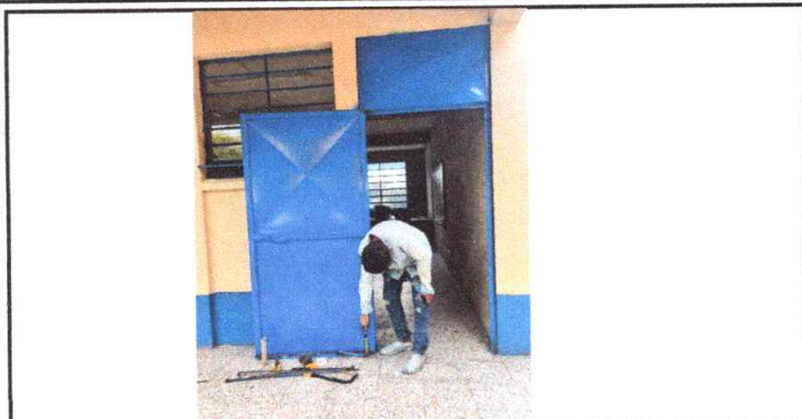
Foto1: MANTENIMIENTO A PUERTA, LIJADO CAMBIO DE TUBO Y LAMINA Y PINTURA ANTICORROSIVA
