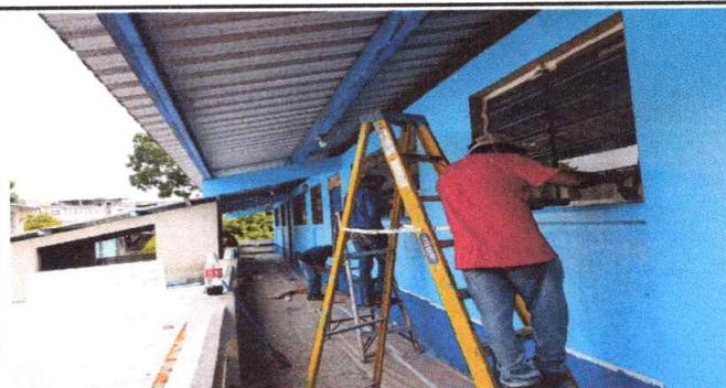
Foto 4: SUMINISTRO Y APLICACIÓN PINTURA EXTERIOR EN MUROS
