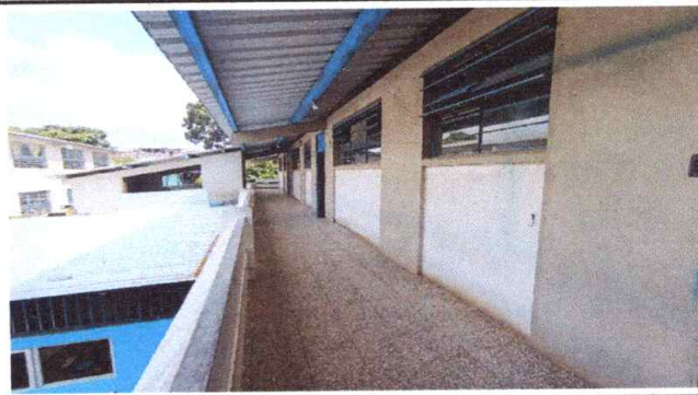
FOTO 4: SUMINISTRO Y APLICACIÓN PINTURA EXTERIOR EN MUROS
