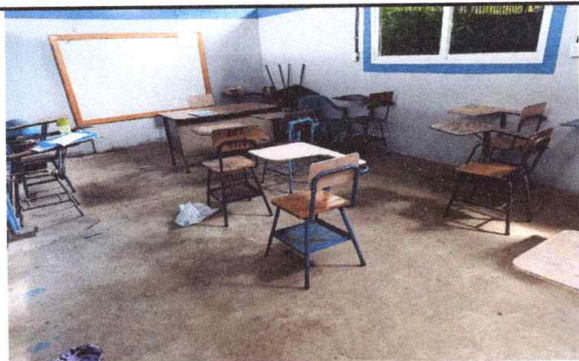
FOTO 3: SUSTITUCION DE PISO DE CONCRETO POR CERÁMICO
