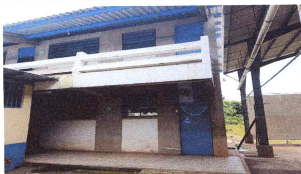
FOTO 2: SUMINISTRO Y APLICACIÓN PINTURA EXTERIOR EN MUROS
