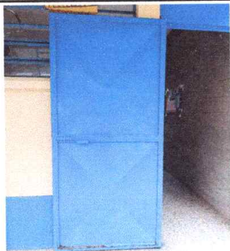
FOTO 1: MANTENIMIENTO A PUERTAS, LIJADO CAMBIO DE TUBO Y LAMINA Y PINTURA ANTICORROSIVA.
