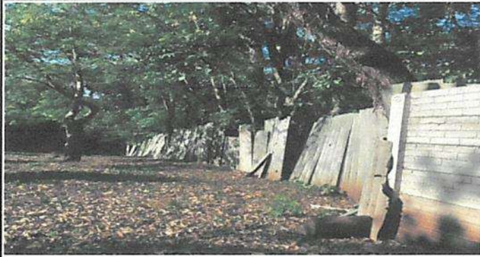
Sustitución de contención de block,
