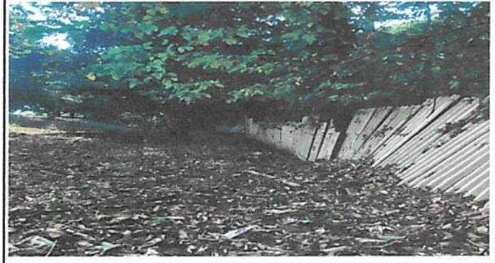
Sustitución muro perimetral de asbesto cemento por placas y postes de concreto reforzado
