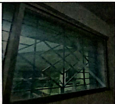
Foto No. 5: Sustitución de vidrio 5 mm. 20.20 de metros cuadrados.
