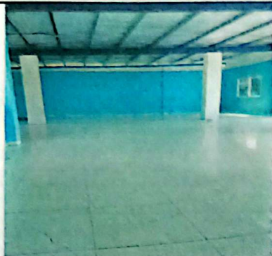
Foto No. 1: Repello en muro. 250 metros cuadrados
