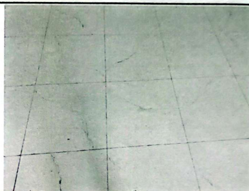
Foto No. 4: Sustitución de piso cerámico. 180 metros cuadrados
