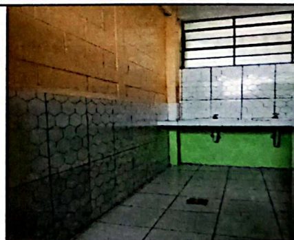
Foto No. 6: Sustitución de azulejo. 80 metros cuadrados, para servicios sanitarios de hombres y mujeres en el primer nivel.
