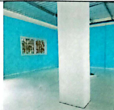
Foto No. 2: Alisado de muro. 250 metros cuadrados.
