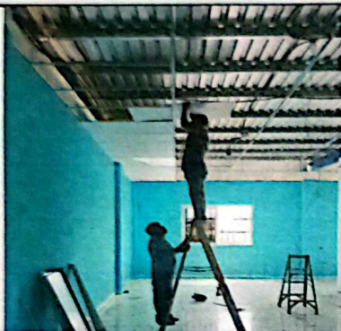
Foto No. 3: Reparación de cubierta con cielo falso de PVC. 160 metros cuadrados.
