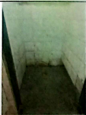
Foto No.7 Sustitución de piso cerámico en baños. 90 metros cuadrados de piso cerámico, en servicios sanitarios de hombres y mujeres del primer nivel.
