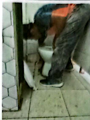
FOTO N.8 Sustitución de inodoro elongado. 4 unidades
