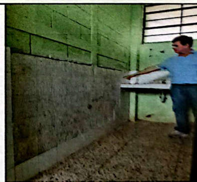
Foto No. 6: Sustitución de azulejo. 80 metros cuadrados.
