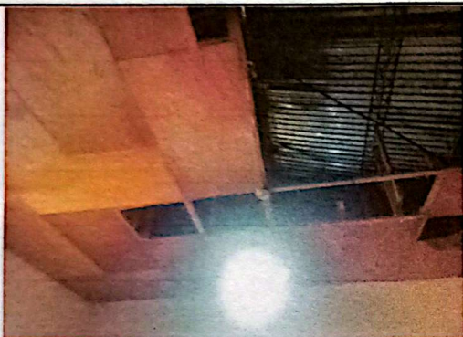
Foto No. 3: Reparación de cubierta con cielo falso de PVC. 160 metros cuadrados
