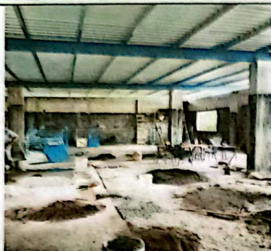
Foto No.1: Repello en muro. 250 metros cuadrados
