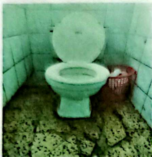
Foto No.7 Sustrucción de piso cerámico en baños. 90 metros cuadrados
