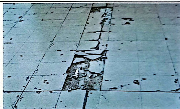
Foto No. 4: Sustitución de piso cerámico. 180 metros cuadrados
