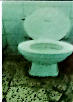
FOTO N.8 Sustrucción de inodoro elongado. Cuatro unidades
