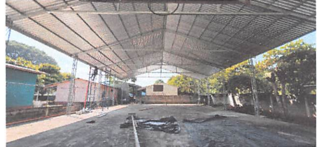
FOTO 2: Sustrucción de lámina por lámina troquelada calibre 26, 250 unidad
