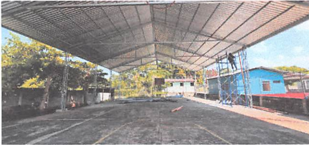
FOTO1: Sustrucción de estructura de soporte de madera por metal, 252 m2
