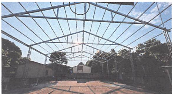
FOTO1: Sustrucción de estructura de soporte de madera por metal, 252 m2
