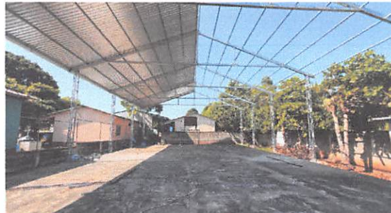
FOTO 2: Sustrucción de lámina por lámina troquelada calibre 26, 250 unidad
