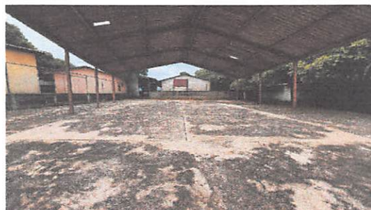
FOTO 2: Sustrución de lámina por lámina troquelada calibre 26, 250 unidad
