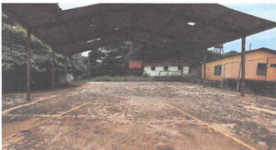
FOTO1: Sustrución de estructura de soporte de madera por metal, 252 m2
