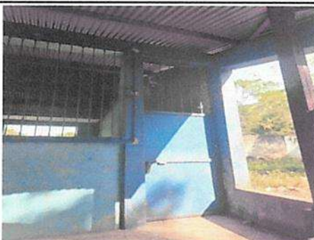
FOTO No. 5 MANTENIMIENTO DE BALCONES Y PUERTAS
