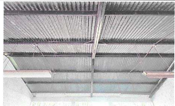
FOTO No. 2 MANTENIMIENTO E INSTALACIÓN DE ESTRUCTURA METALICA
