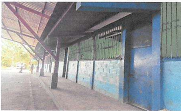
FOTO No. 3 SUSTITUCIÓN DE CANAL Y BAJADA DE AGUA
