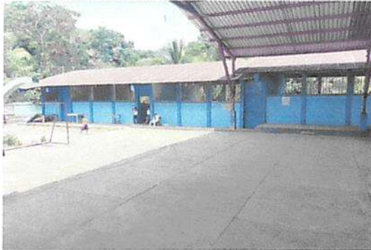
FOTO No. 1 SUSTITUCIÓN DE TECHO O CUBIERTA DE LAMINA POR LAMINA TROQUELADA CALIBRE 26
