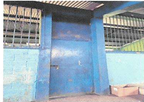
FOTO No. 4 MANTENIMIENTO DE BALCONES Y PUERTAS
