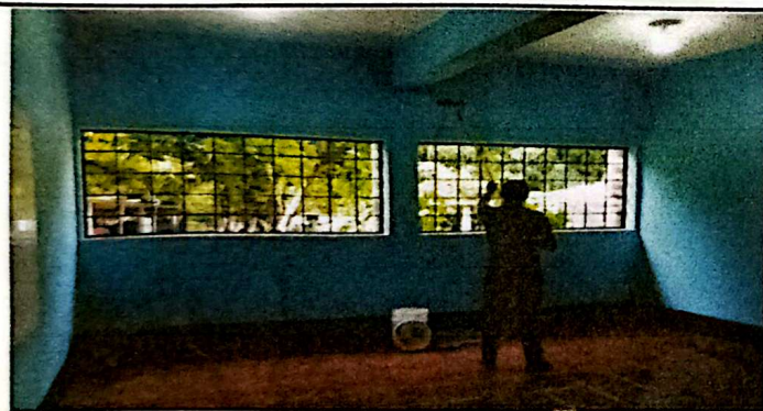
Foto 3: Suministro y aplicación de pintura interior y exterior para muros
