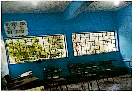
Suministro y aplicación de pintura interior y exterior para muros
