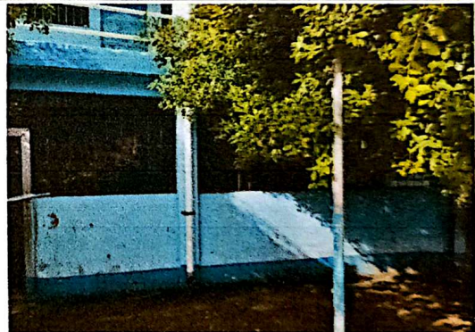
Suministro y aplicación de pintura interior y exterior para muros
