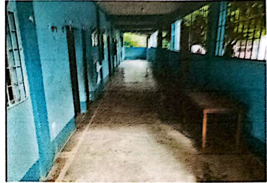
Sustitución de piso de concreto a piso ceramico (corredor)
