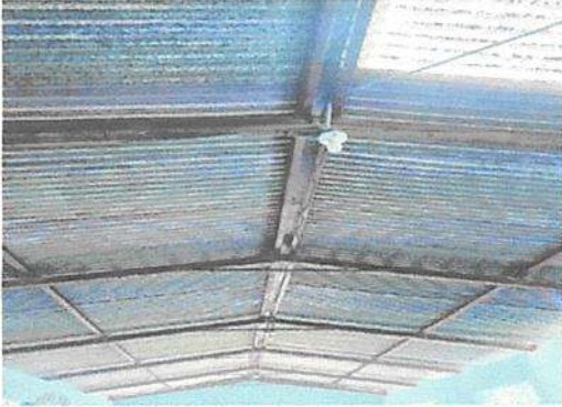
Foto 1: SUSTITUCIÓN DE TECHO O CUBIERTA DE LAMINA
