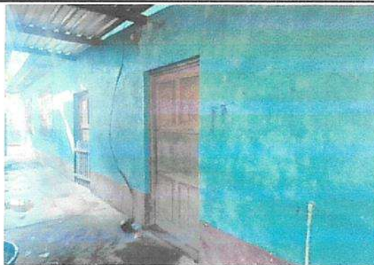
Foto 12: RAPARACIÓN / MANTENIMIENTO DE PINTURA EN PAREDES EXTERIOR E INTERIOR
