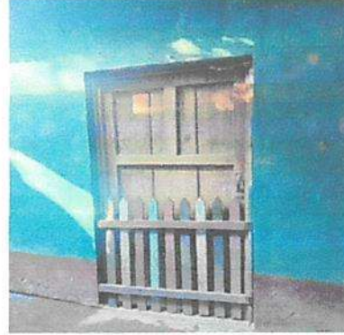
Foto 4: SUSTITUCIÓN DE PUERTAS DE MADERA POR METAL
