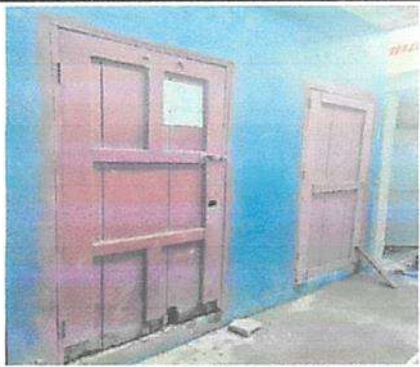
Foto 5: SUSTITUCION DE PUERTAS DE BAÑO
