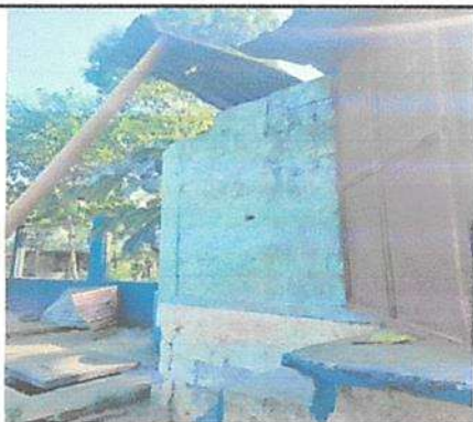
Foto 7: SUSTITUCIÓN Y MANTENIMIENTO DE ESTRUCTURA PORTANTE DE TECHO DE BODEGA
