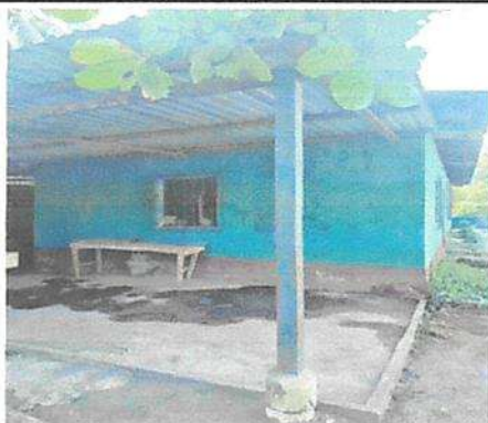
Foto 11: REPARACIÓN / SUSTITUCIÓN DE PISO DE TORTA DE CONCRETO
