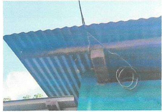
Foto 2: MANTENIMIENTO DE ESTRUCTURA METALICA
