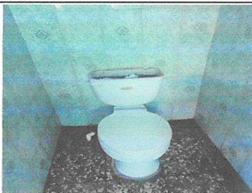
Foto 9: SUSTITUCION DE INODORO ELONGADO
