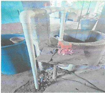
Foto 3: SUSTITUCIÓN DE SISTEMA DE AGUA POTABLE
