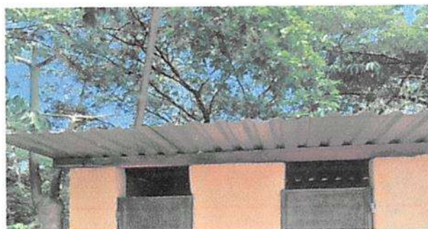
Foto 8: SUSTITUCIÓN DE ESTRUCTURA METALICA DE TECHO BAÑO
