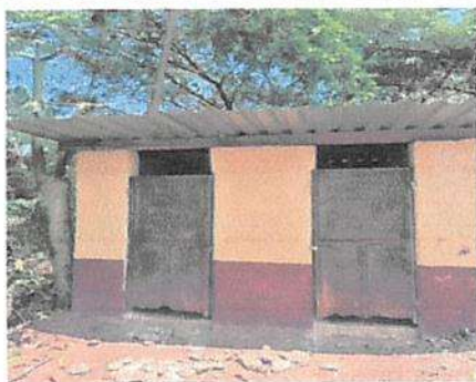
Foto 9: REPARACIÓN Y MANTENIMIENTO DE PINTURA DE PAREDES DE BAÑOS
