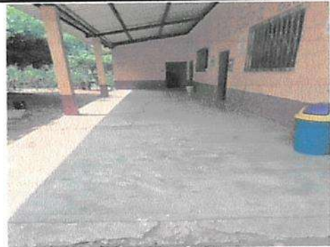
Foto 4: SUSTITUCIÓN Y MANTENIMIENTO DE PISO
