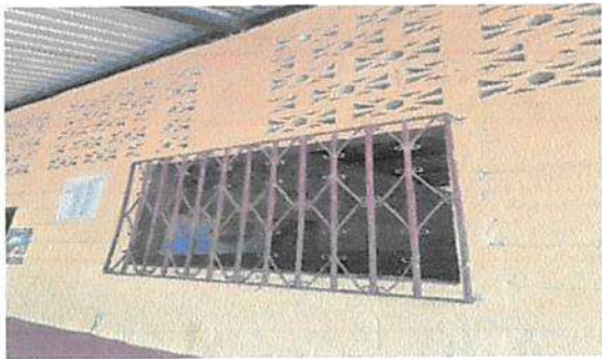
Foto 7: PINTURA DE PAREDES DE AULAS INTERIOR Y EXTERIOR
