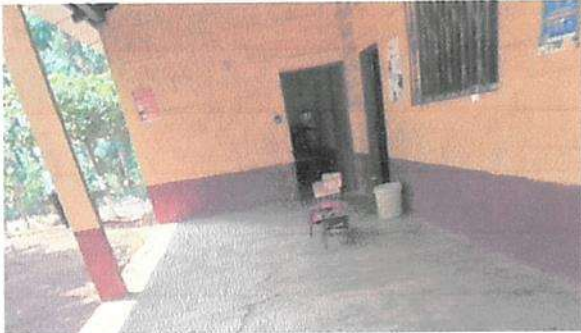
Foto 3: SUSTITUCIÓN DE PUERTAS DE AULAS
