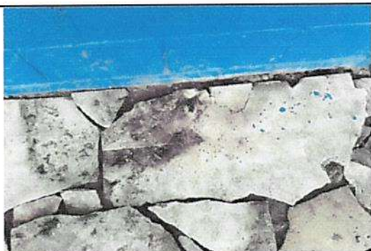
Reparación de plancha de concreto de patio
