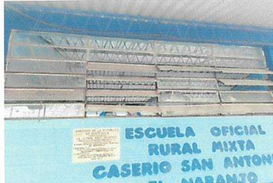
Sustitución de balcones
