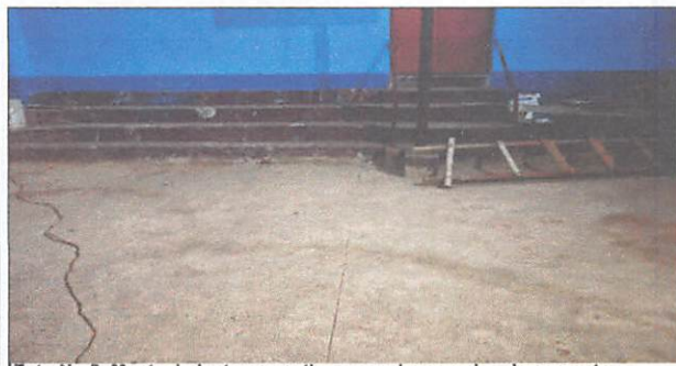
Foto No.5: Mantenimiento correctivo a cancha con piso de concreto
