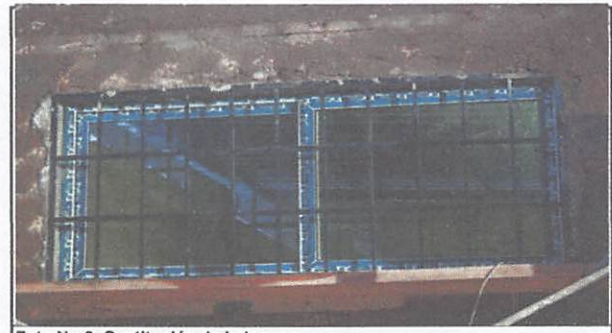
Foto No.6: Sustitución de balcones
