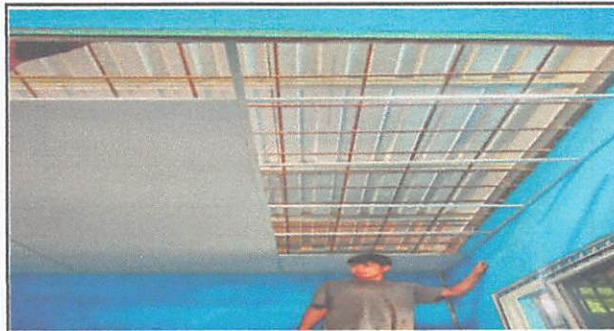
Foto No.3: Reparación de cubierta con cielo falso de PVC
