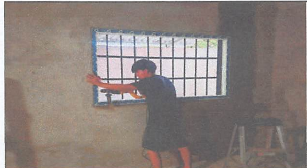
Foto No.4: Sustitución de ventanas de madera a PVC
