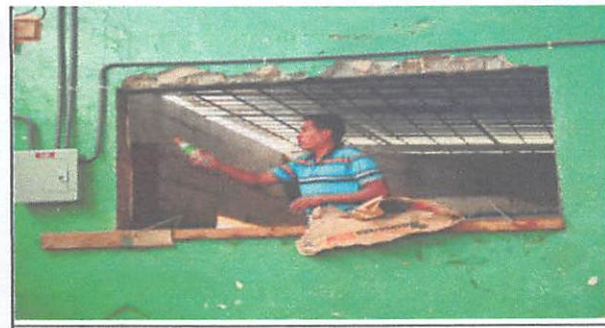
Foto No.6: Sustitución de balcones
