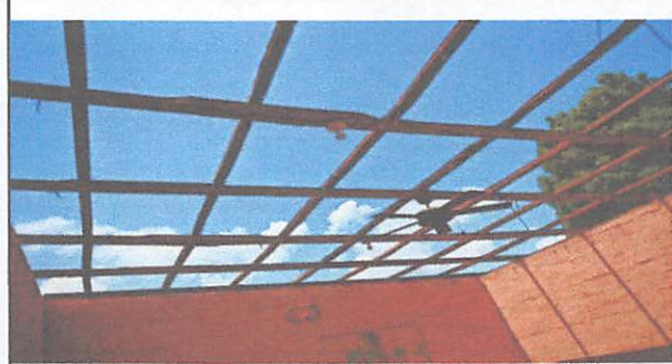
Foto No.2: Sustitución de lámina, por lámina troquelada calibre 26
