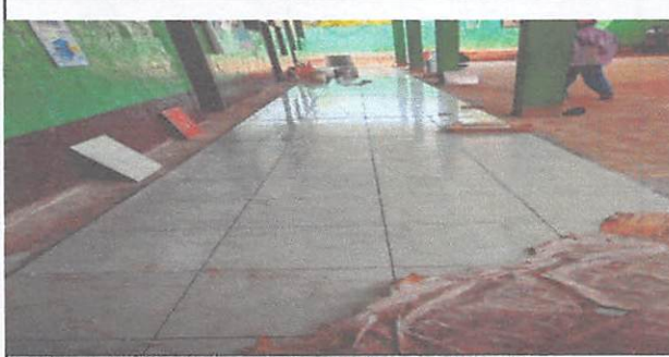
Foto No.1: Sustitución de piso de concreto a piso cerámico
