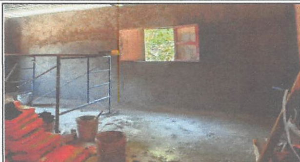
Foto No.7: Repello gris en muro
