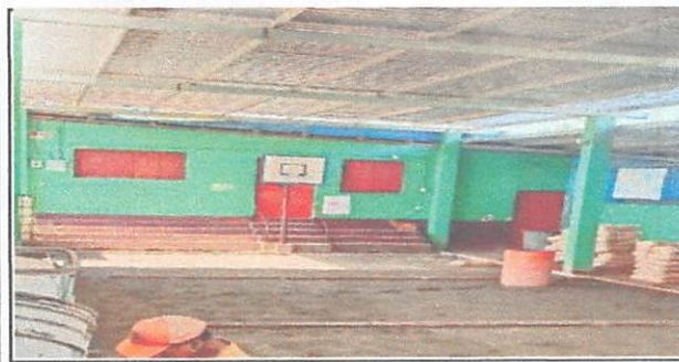
Foto No.5: Mantenimiento correctivo a cancha con piso de concreto
