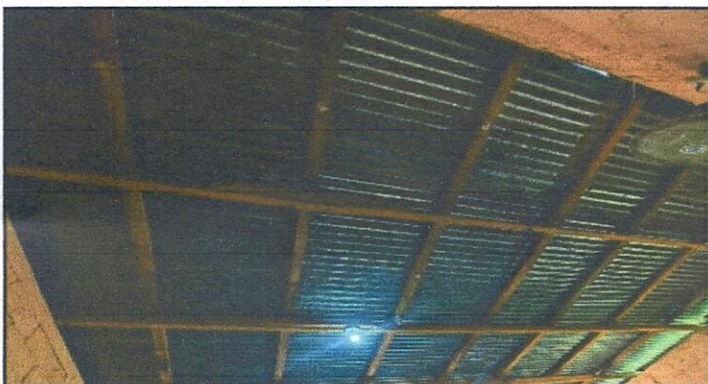
Reparación de cubierta con cielo falso de PVC
