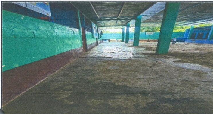
Sustitución de piso de concreto a piso cerámico
