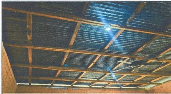
Sustitución de lamina, por lámina troquelada calibre 26
