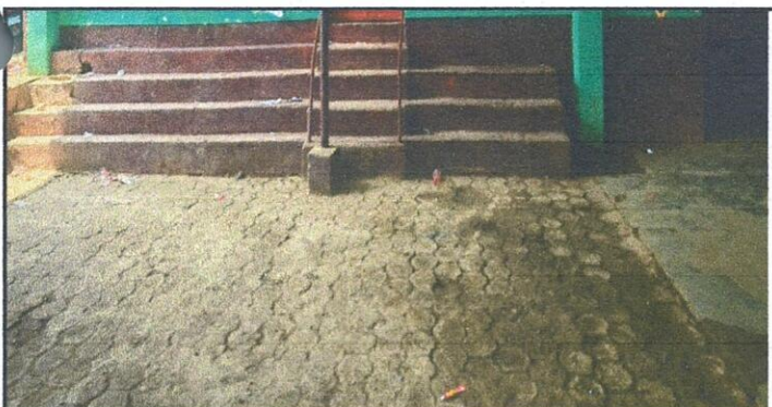
Mantenimiento correctivo a cancha con piso de concreto
