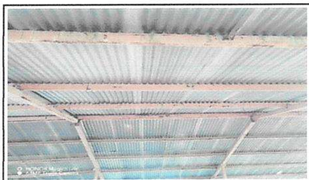
Mantenimiento a estructura de soporte de metal con anticorrosivo
