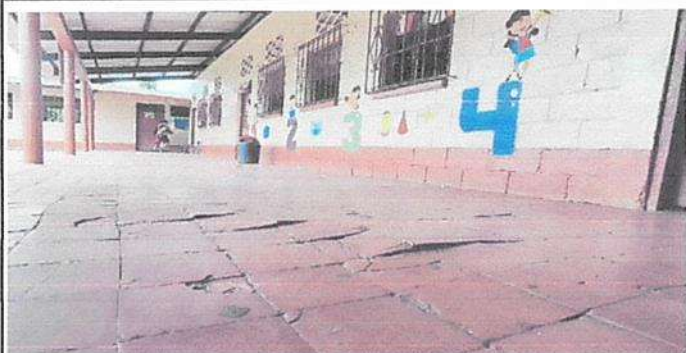
Sustitución de piso cerámico
