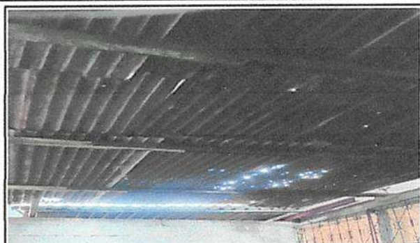
Sustitución de lámina, por lámina troquelada Calibre 26
