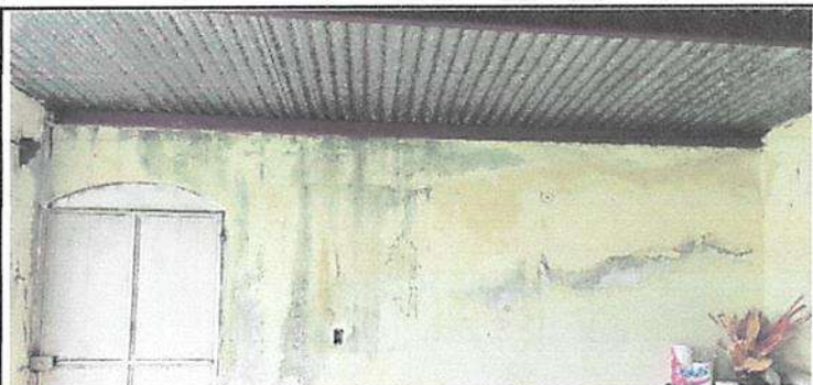
Suministro y aplicación de pintura interior látex lavable (limpieza, resane y aplicación)
