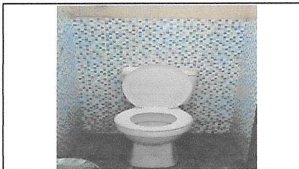
Sustitución de inodoro elongado
