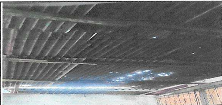
Sustitución de estructura de soporte (maderal) por metal
