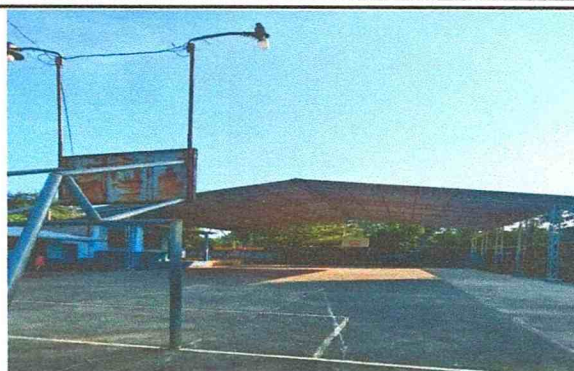
Foto #2: Sustitución de lámina por lámina troquelada cal. 26 de 270 m2
