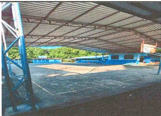
Foto #1: Sustitución de estructura de soporte de madera por metal de 270 m2
