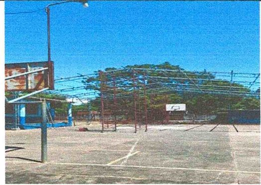
Foto #2: Sustitución de lámina por lámina troquelada cal. 26 de 270 m2
