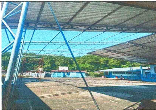
Foto #3: Sustitución de bases de madera por metal 8 unidades (bases)
