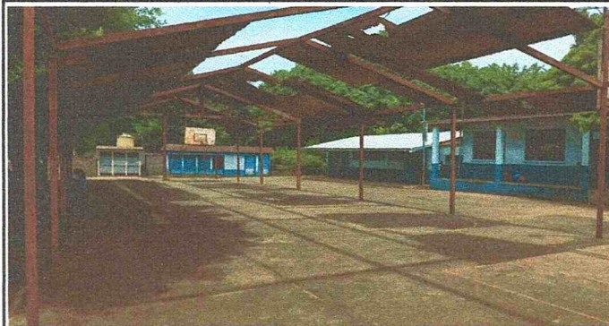
Foto #1: Sustitución de estructura de soporte de madera por metal de 270 m2
