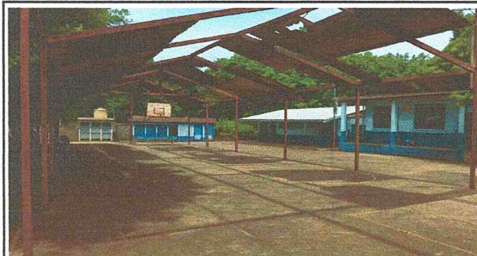
Foto #3: Sustitución de bases de madera por metal 8 unidades (bases).
