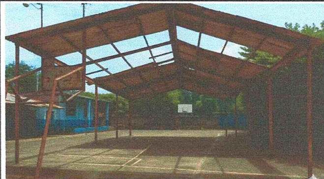
Foto #2: Sustitución de lámina por lámina troquelada cal. 26 de 270 m2
