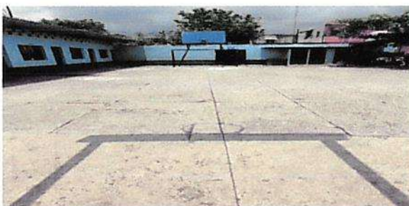
5. Sustitución de torta de concreto en cancha.
