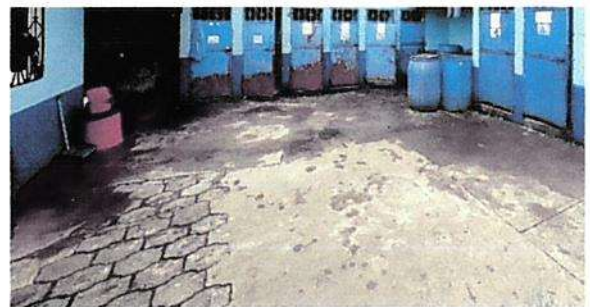
4. Sustitución de tubería de agua principal en sanitarios.
