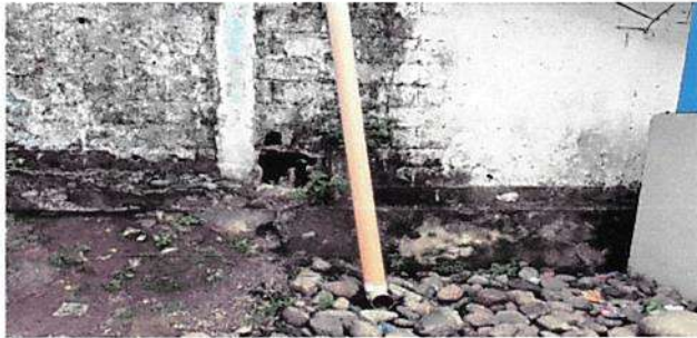
1. Sustitución de muro perimetral existente de block.
