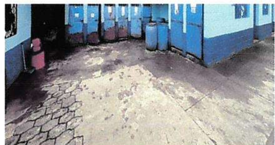
5. Sustitución de torta de concreto en patio de sanitarios.
