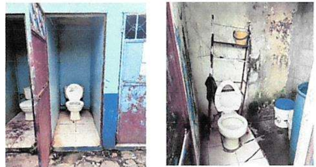
2. Sustitución de sanitarios lavables.
