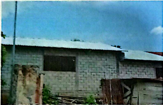
Sustitución de lámina por lámina troquelada calibre 26
