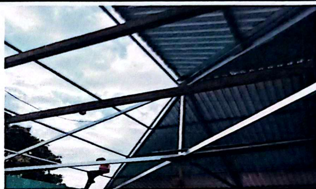
Sustitución de estructura de soporte (madera, metal) por metal
