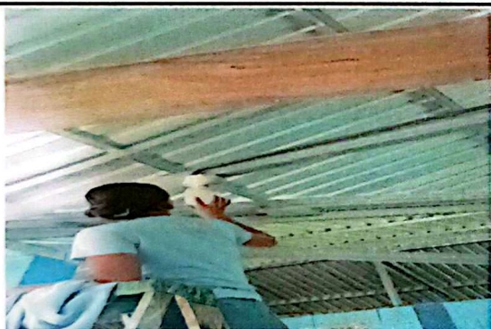
Sustitución de una lámpara existente con lámpara bombillo led 30 wats para pasillo 2400 lumines
