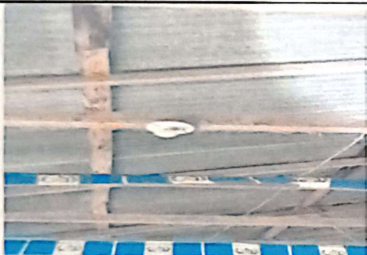
Sustitución de una lámpara existente con lámpara bombillo led 30 wats para pasillo 2400 lumines
