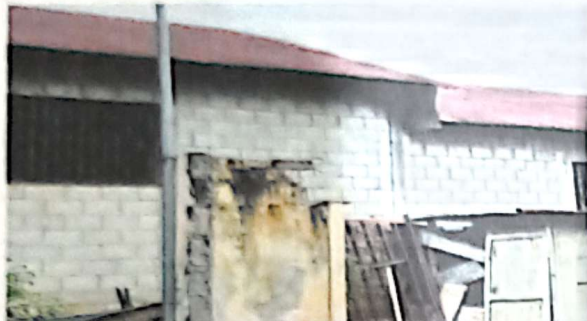
Sustitución de lámina por lámina troquelada calibre 26
