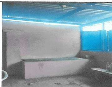
Foto 5: MANTENIMIENTO DE ESTUFA INDUSTRIALIZADA
