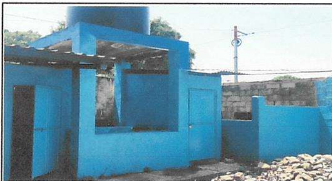
Foto 3: SUSTITUCIÓN DE ESTRUCTURA METÁLICA
