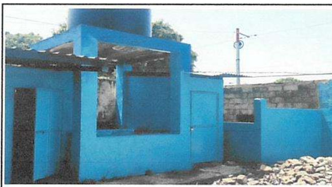
Foto 4: SUSTITUCIÓN DE TECHO O CUBIERTA DE LAMINA
