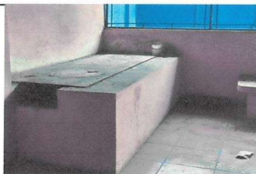
Foto 5: MANTENIMIENTO DE ESTUFA INDUSTRIALIZADA
