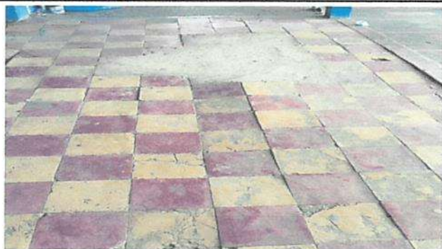
Foto 1: REPARACIÓN Y SUSTITUCIÓN DE PISO CERÁMICO
