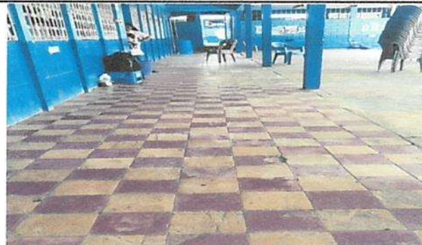
Foto 2: REPARACIÓN Y SUSTITUCIÓN DE PISO CERÁMICO
