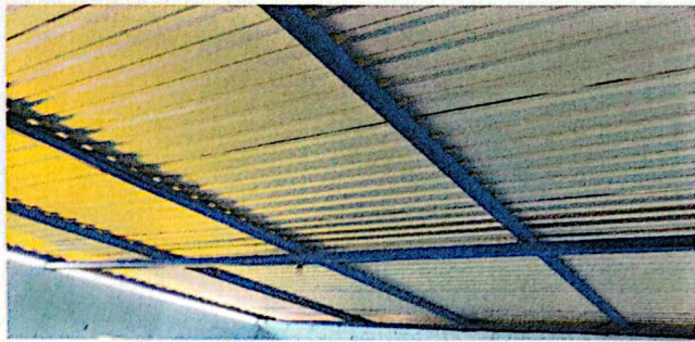
Sustitución de lámina, por lámina troquelada Calibre 26 - m2. 261.00
