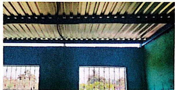
Mantenimiento a estructura de soporte de metal con anticorrosivo - m2. 261.00
