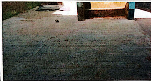
Sustitución de piso de torta de concreto - m2. 549.00
