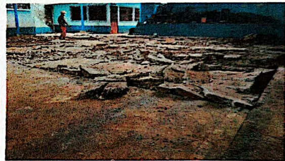
Mantenimiento de piso de cancha deportiva con suministro y aplicación de pintura colores (limpieza, resane y aplicación) - m2. 515.00
