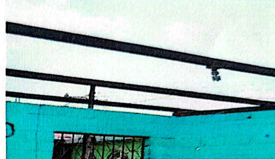
Mantenimiento a estructura de soporte de metal con anticorrosivo - m2. 261.00
