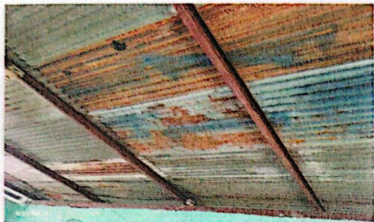
Sustitución de lámina, por lámina troquelada Calibre 26 - m2 261.00
