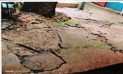
Sustitución de piso de torta de concreto - m2 549.00
