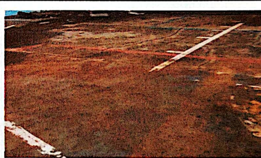
Mantenimiento de piso de cancha deportiva con suministro y aplicación de pintura colores (limpieza, resane y aplicación) - m2 515.00
