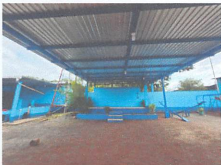
FOTOGRAFIA 5. SUMINISTRO E INSTALACION DE ESTRUCTURA DE SOPORTE DE METAL GALVANIZADO
