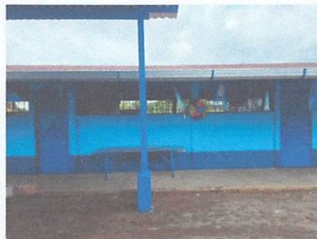
FOTOGRAFIA 2. SUMINISTRO Y APLICACIÓN DE PINTURA EN MUROS EXTERIORES, PINTURA ALQUÍDICA MARCA CORONA
