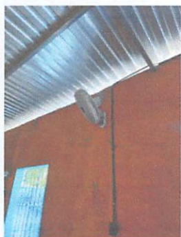
FOTOGRAFIA 3. SUSTITUCION DE VENTILADOR MARCA NAVIA 16"
