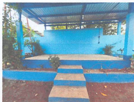
FOTOGRAFIA 4. SUMINISTRO E INSTALACION DE CUBIERTA DE LAMINA POR LAMINA TROQUELADA CALIBRE 26 ALUZINC
