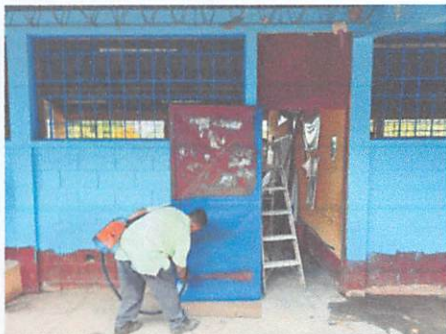
FOTOGRAFIA 1. SUMINISTRO Y MANTENIMIENTO A PUERTAS, LIJADO Y PINTURA CON ANTICORROSIVO.
