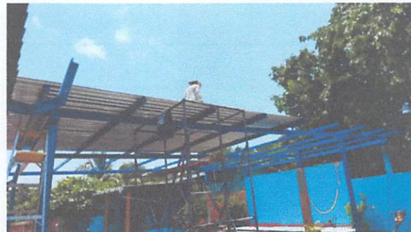
FOTOGRAFIA 4. SUMINISTRO E INSTALACION DE CUBIERTA DE LAMINA POR LAMINA TROQUELADA CALIBRE 26 ALUZINC
