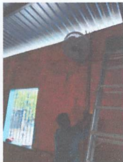
FOTOGRAFIA 3. SUSTITUCION DE VENTILADOR MARCA NAVIA 16"
