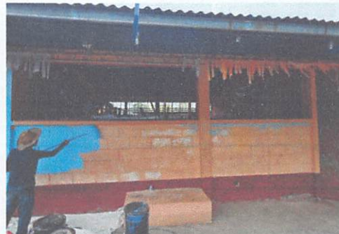
FOTOGRAFIA 2. SUMINISTRO Y APLICACIÓN DE PINTURA EN MUROS EXTERIORES, PINTURA ALQUIDICA MARCA CORONA
