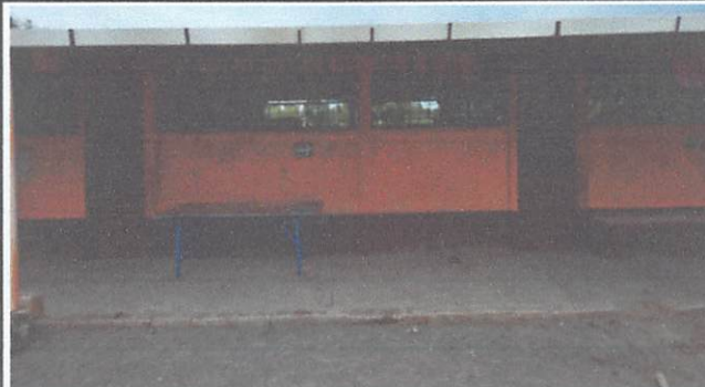
FOTOGRAFIA 2. SUMINISTRO Y APLICACIÓN DE PINTURA EN MUROS EXTERIORES, PINTURA ALQUÍDICA MARCA CORONA
