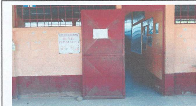
FOTOGRAFIA 1. SUMINISTRO Y MANTENIMIENTO A PUERTAS, LIJADO Y PINTURA CON ANTICORROSIVO.
