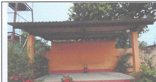
FOTOGRAFIA 5. SUMINISTRO E INSTALACION DE ESTRUCTURA DE SOPORTE DE METAL GALVANIZADO
