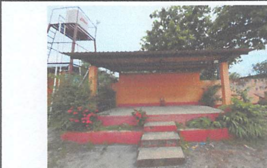
FOTOGRAFIA 4. SUMINISTRO E INSTALACION DE CUBIERTA DE LAMINA POR LAMINA TROQUELADA CALIBRE 26 ALUZINC
