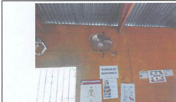
FOTOGRAFIA 3. SUSTITUCION DE VENTILADOR MARCA NAVIA 16"
