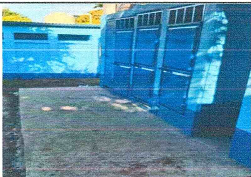
Foto #3: Sustitución de piso de concreto por concreto. 5 m2
