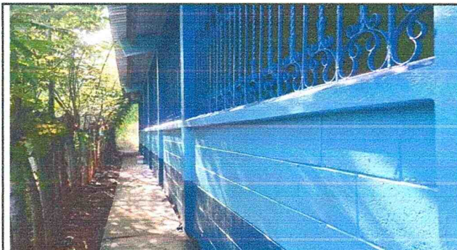
Foto #4: Mantenimiento de balcones. 85 m2
