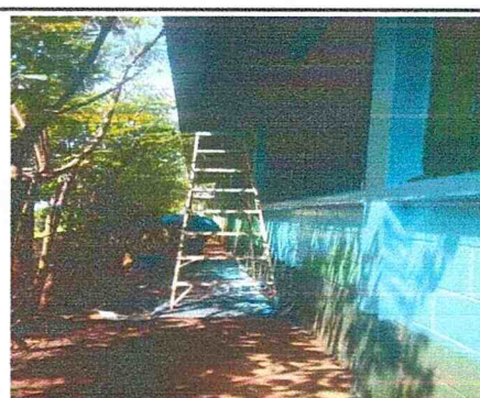
Foto #4: Mantenimiento de balcones. 85 m2
