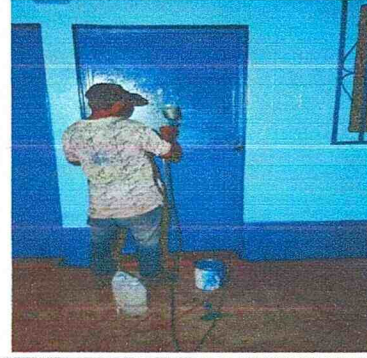
Foto #8: Mantenimiento de puertas (lijado, cambio de tubo, cepillado, aplicación de pintura). 8 puertas
