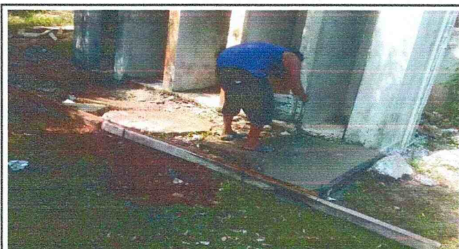
Foto #3: Sustitución de piso de concreto por concreto. 5 m2
