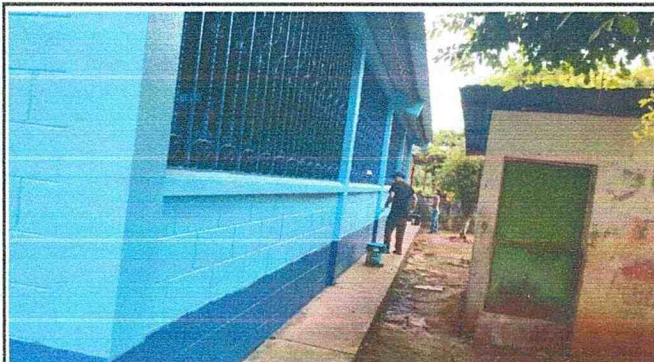
Foto #2: Suministro y aplicación de pintura en paredes de aulas exterior. 500 m2
