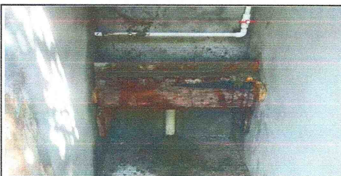
Foto #5: Sustitución de migitorio de cemento. 3 migitorio de cemento
