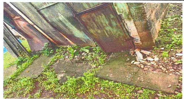
Foto #6: Sustitución de puerta metálica. 3 Puertas
