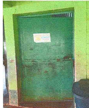
Foto #8: Mantenimiento de puertas (lijado, cambio de tubo, cepillado, aplicación de pintura). 8 puertas
