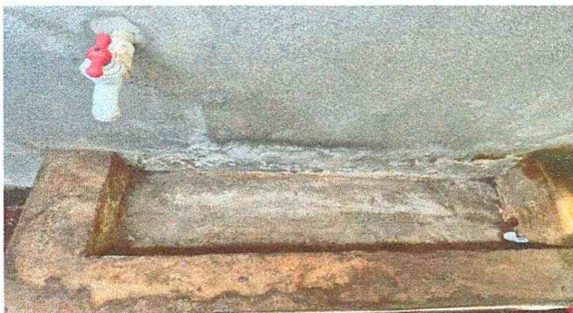
Foto #7: Sustrucción de lavamanos de concreto. 2 lavamanos de concreto
