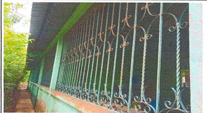
Foto #4: Mantenimiento de balcones. 85 m2
