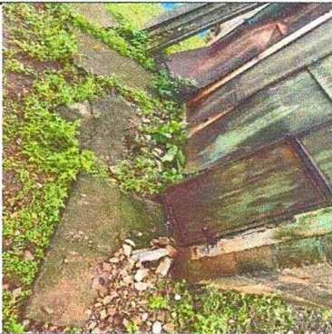
Foto #3: Sustitución de piso de concreto por concreto. 5 m2
