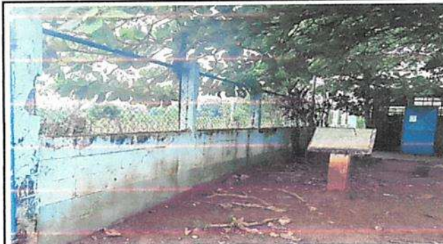
Repello en muro
