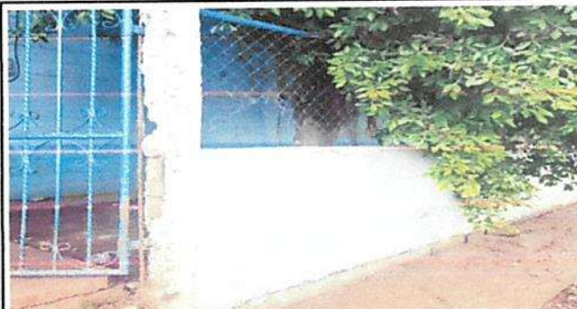
Suministro y aplicación pintura exterior e interior
