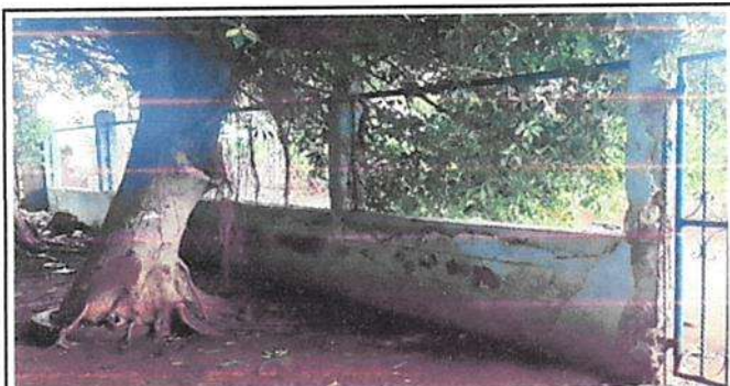
Reparación de muro perimetral existente de block con tubo HG y malla galvanizada y columnas
