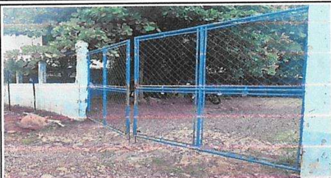
Sustitución de portón de malla por portón metálico
