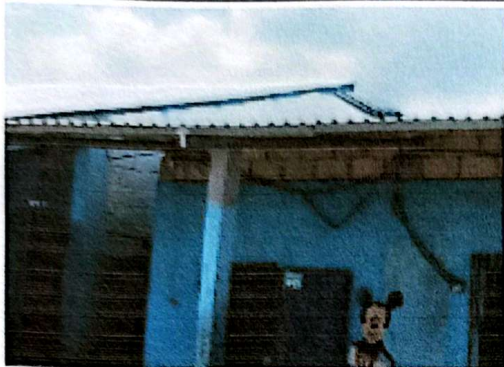
Foto 1. Sustitución de cubierta de lámina acanalada por lámina troquelada aluzinc calibre 26
