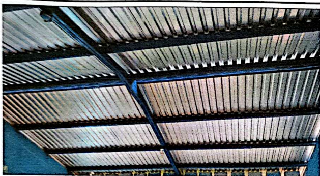
Foto 3. Mantenimiento de estructura de soporte de metal con anticorrosivo
