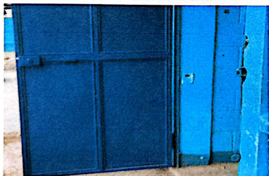
Foto 5. Sustitución de puerta metálica con chapa yale
