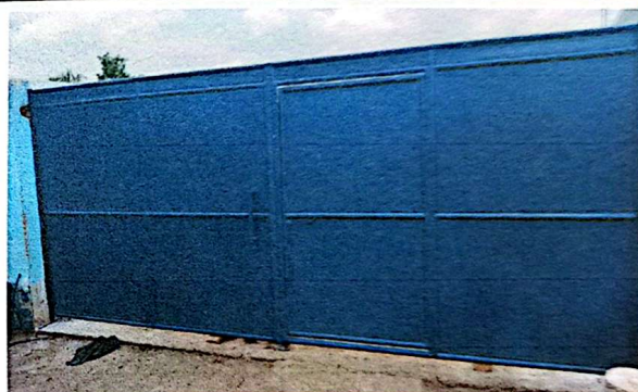
Foto 4. Sustitución de portón metálico con chapa yale y puerta central
