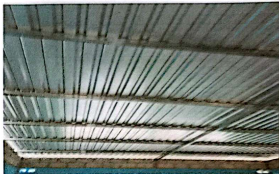
Foto 2. Sustitución de estructura de metal por metal galvanizado chapa 16
