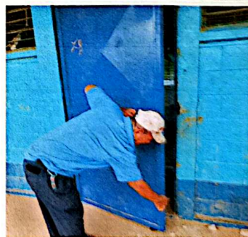
Foto 6. Mantenimiento a puertas incluye lijado, cambio de tubo, cepillado, sujeciones, aplicación de pintura anticorrosiva
