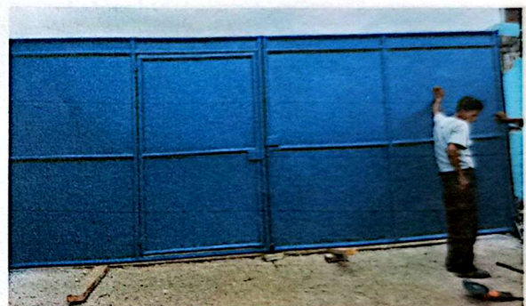
Foto 4. Sustitución de portón metalico con chapa yale y puerta central
