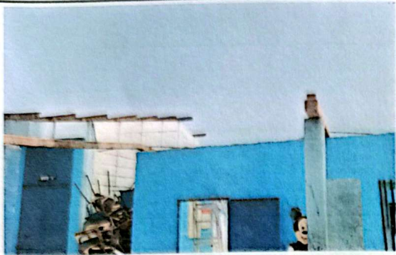
Foto 1. Sustitución de cubierta de lámina acanalada por lámina troquelada aluzinc calibre 26
