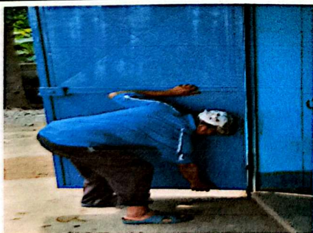
Foto 5. Sustitución de puerta metalica con chapa yale
